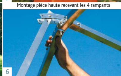
Montage pièce haute recevant les 4 rampants
