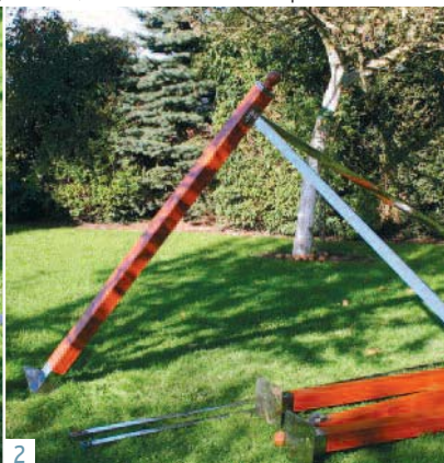
montage du cadre, emboîtement sablières sur poteaux
