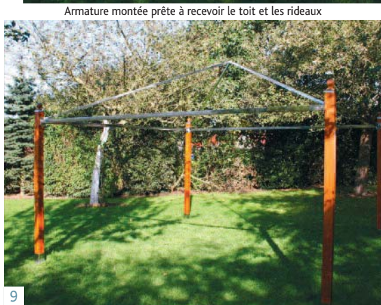
Armature montée prête à recevoir le toit et les rideaux
