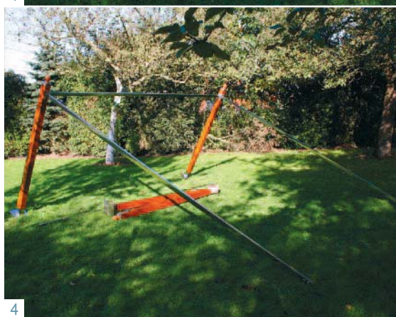
Armature montée prête à recevoir le toit et les rideaux
