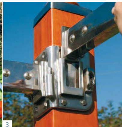
Montage pièce haute recevant les 4 rampants
